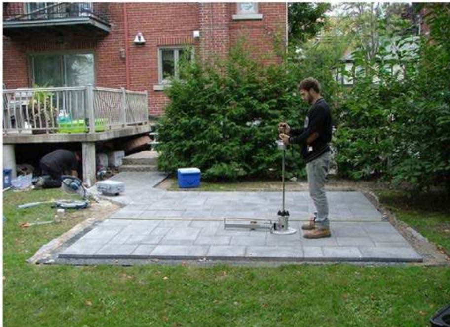
Photo 3 204, Av. Dufferin à Hampstead - Position du patio arrière cours 206° S.O. entouré d'une haie cotée maison et d'arbre mature section arrière
