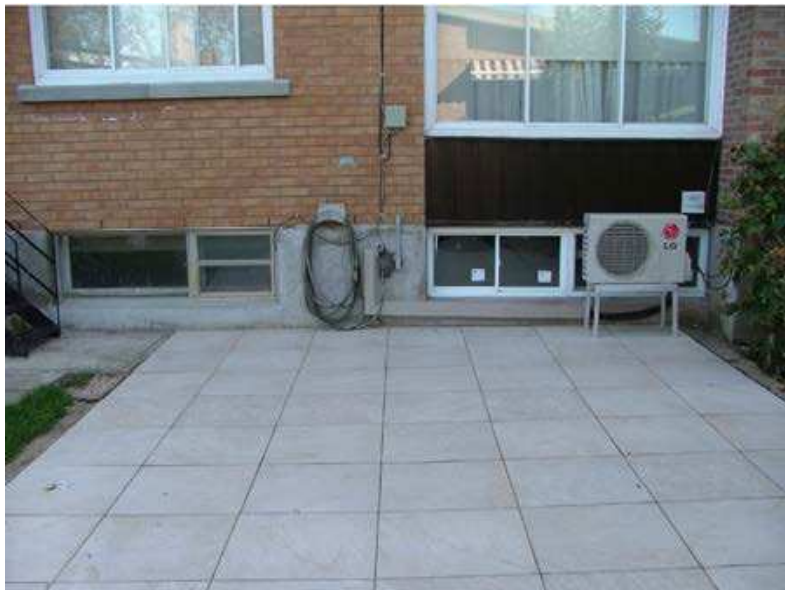
Photo 1 67, Croissant Roxton dans Montréal Ouest - Position du patio cours arrière 308° N.O. Entouré mur de la maison et unité de climatisation et une haie de cèdre partie arrière et côté opposé de la maison.
